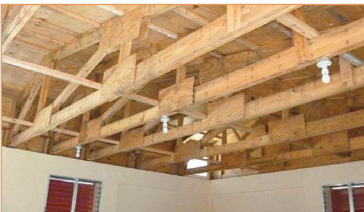
Dettaglio soffitto aule
