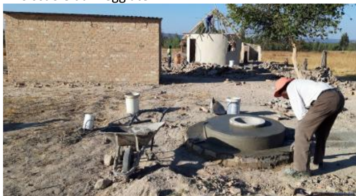
Realizzazione di un pozzo artesiano
