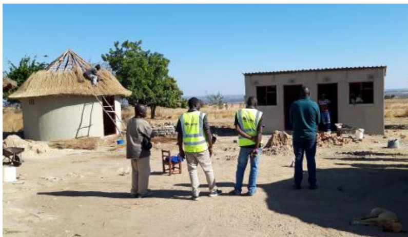
Nuova abitazione in via di ultimazione
