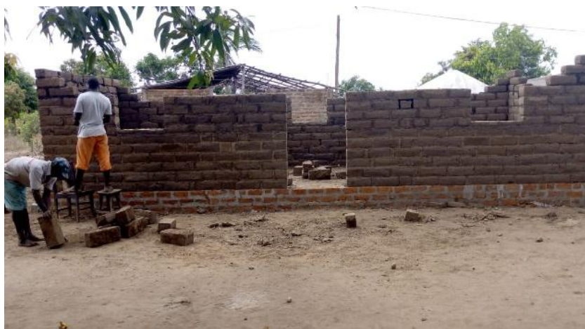
Una delle case pilota in costruzione
