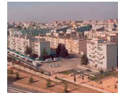
CASERMONI A PERDITA D'OCCHIO Panoramica del quartiere San Paolo, otto chilometri dal centro di Bari
